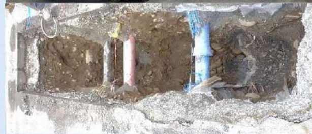
Mise en place de l'assainissement collectif au niveau des branchements avec des terrassements sécurisés par 2 aspiratrices-excavatrices (pour ne pas endommager les réseaux et travailler en sécurité).
