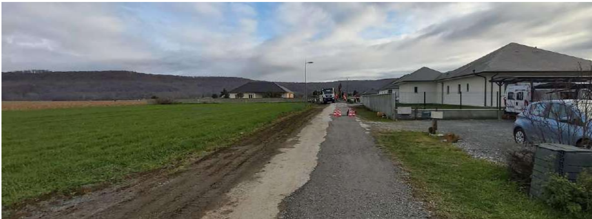
Dernier tronçon d'assainissement collectif rue du Pré du Roy à Beuste (non subventionné par l'Agence de l'eau).
