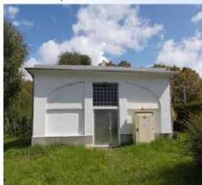
Forage de Lestelle-B
