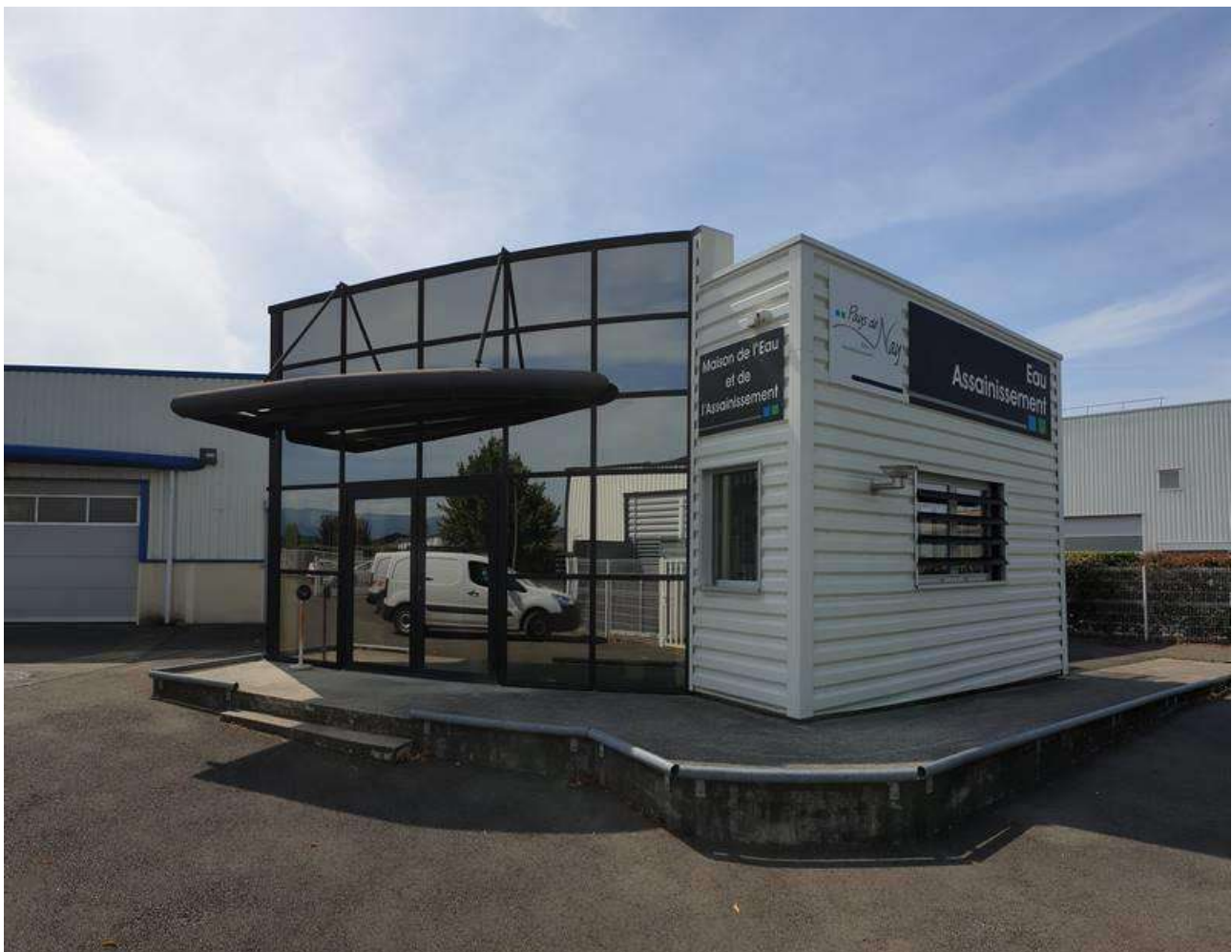
Siège du service des eaux de la CC du Pays de Nay à Bénéjacq depuis janvier 2014.
