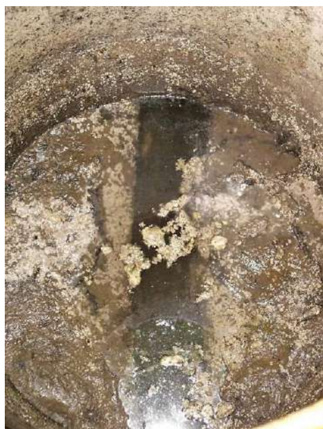
Graisses dans un regard de visite (Provenant d'effluents industriels bruts), non conformes à la collecte (non prétraités) à Bénéjacq / Camion d'hydrocurage en intervention d'urgence.
